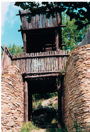
Abb. 9: Das rekonstruierte Süd-Tor der „slawischen“ Befestigungsanlage, Bereich Schanze.
